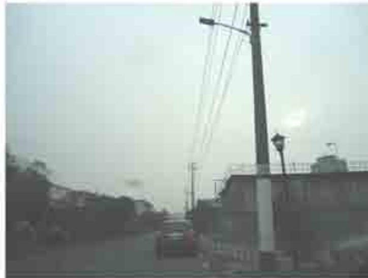
公司南侧的道路及智兴印染净水站
