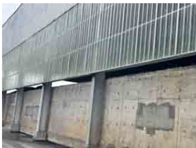
煤堆场(已封闭)
