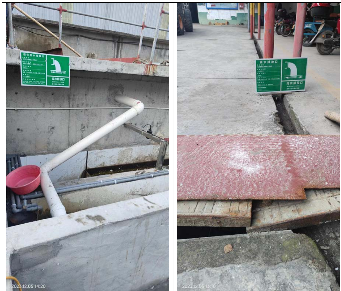
图 4-3 污水处理设施及排放口、雨水排放口照片
