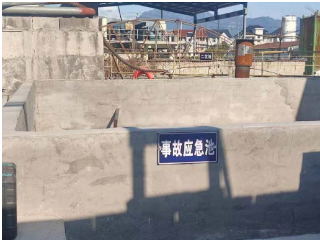
图 4-5 事故应急池照片
