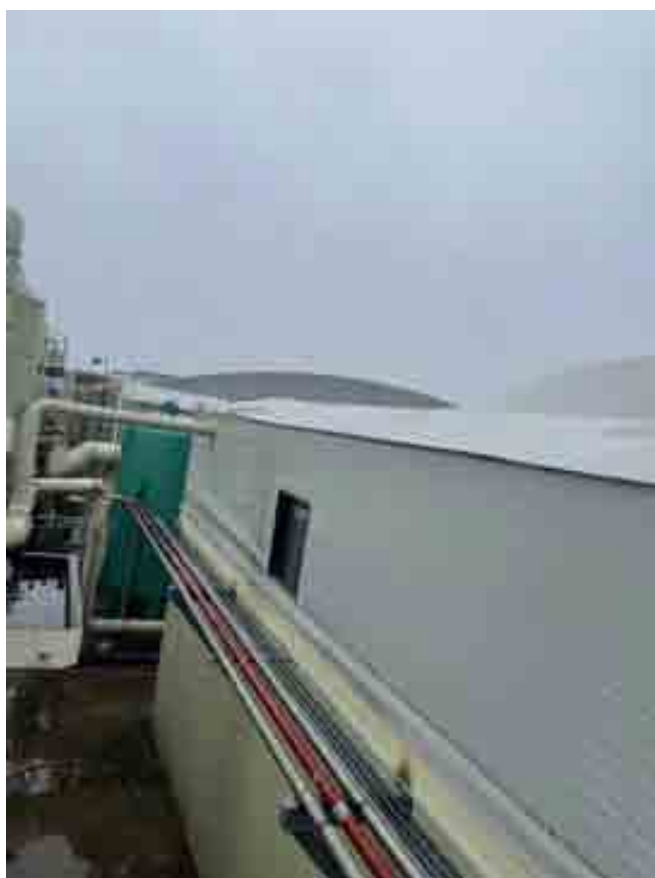
污水处理站构筑物加盖
