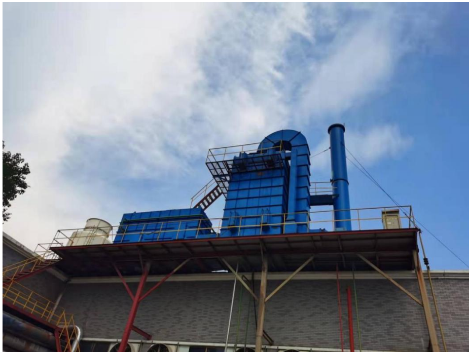
图 2-9 现有定型机废气收集、处理措施现场照片
