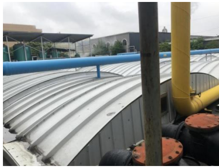
图 2-10 现有污水处理站池体上方加盖照片
