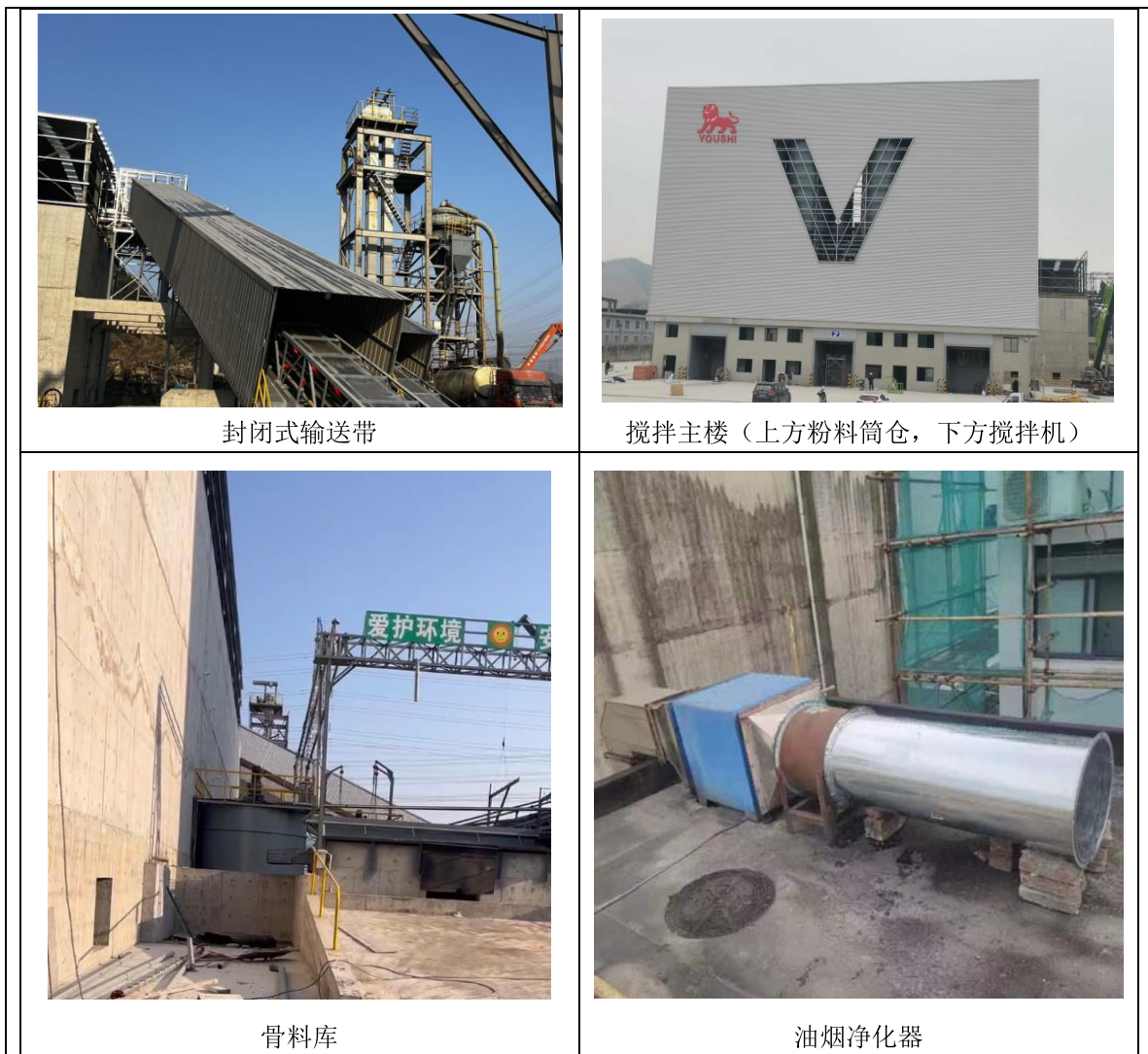
图3-2 废气处理设施
