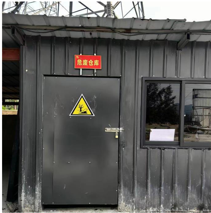
图3-3 危险废物暂存间
